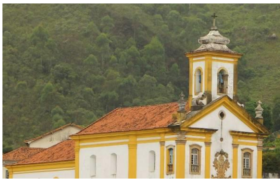
Figura 55: Telhado Igreja Mercês e Misericórdia. Ouro Preto, MG. Fonte: Luana Redini, 2015.
