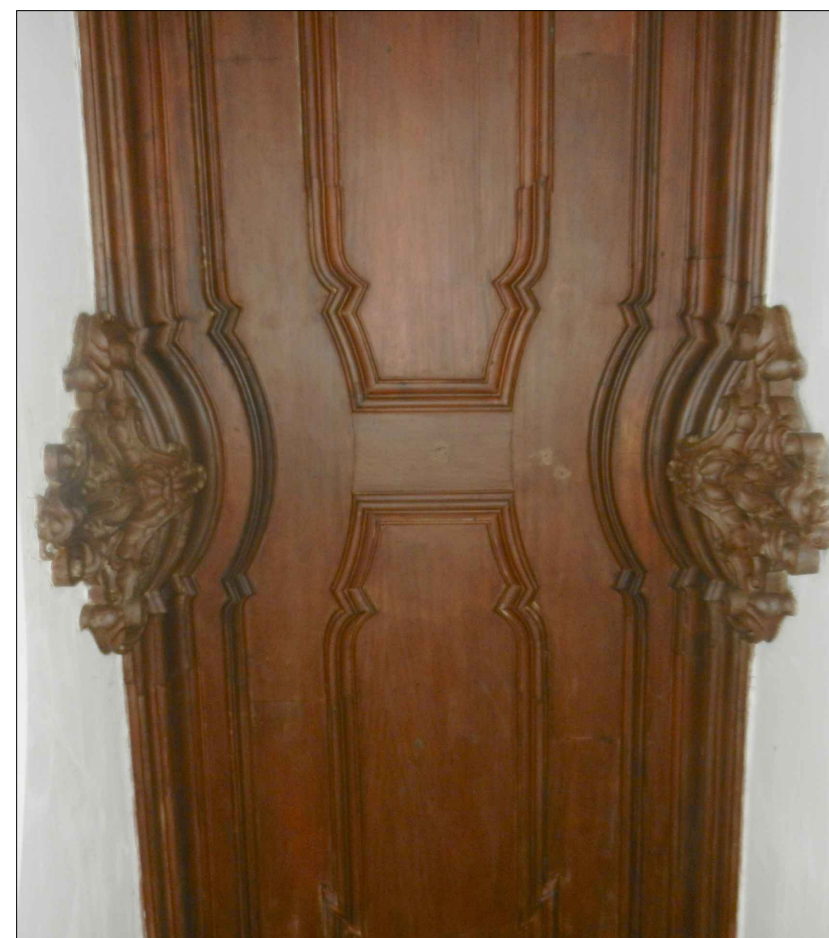
2. Forro plano em madeira
