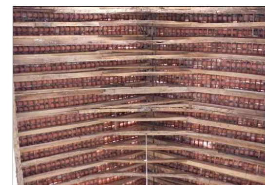
5. Detalhe forro nave
