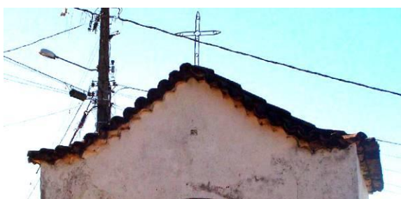
Figuras 51: Detalhe telhado duas águas Capela Santa Cruz, Alto da Cruz. Ouro Preto, MG. Fonte: Luana Redini, 2015.
