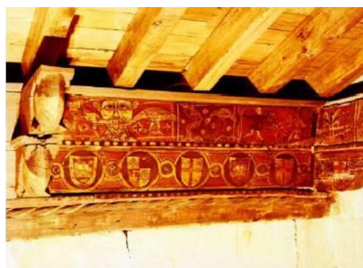
Figura 76: Detalhe estribado da Igreja. Guimarães, Portugal. Fonte: MOREIRA, 2010, p. 32.
