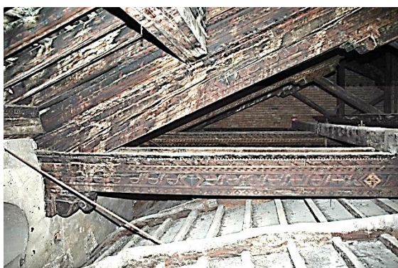
Figura 75: Detalhe pintura da estrutura tesoura da cobertura da igreja de Sant'Egídio. Firenze, Itália. Fonte: RIEL, Silvio Van, 2009.
