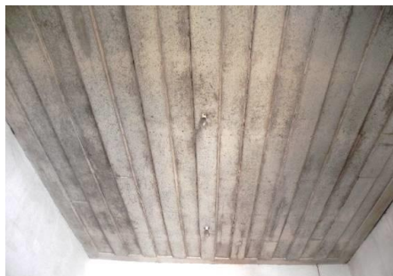
Figura 30: Forro tipo saia e camisa capela de Bom Jesus de Padre Faria, Ouro Preto, MG. Fonte: Luana Redini, 2015.
