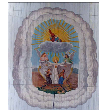
Detalhe forro nave
