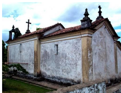
Figura 54: Telhado Capela de São Sebastião. Ouro Preto, MG. Fonte: Luana Redini, 2015.
