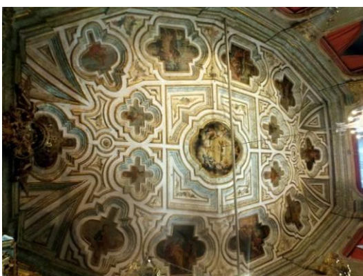
Figura 37: Forro sanqueado da nave da Igreja Matriz de Nossa Senhora do Pilar, Ouro Preto, MG. Fonte: Luana Redini, 2015.
