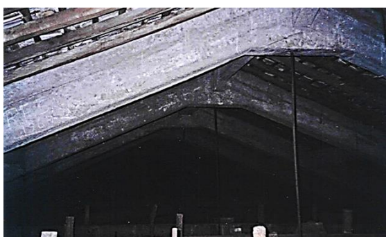
Figura 59: Detalhe do ponto central das tesouras concreto da nave Igreja Matriz de N. Sra. Do Pilar. Ouro Preto, MG. Fonte: IPHAN, 2002.
