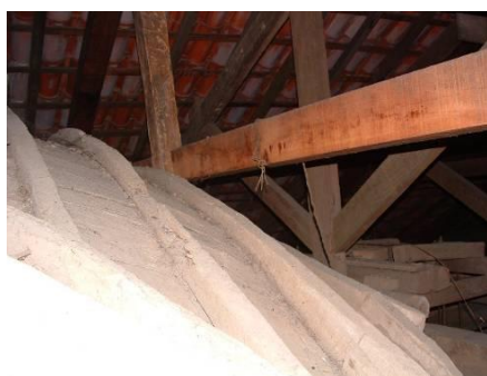
Figura 60: Detalhe tirante forro nave Igreja De Santa Efigênia. Ouro Preto, MG. Fonte: IPHAN, 2002.
