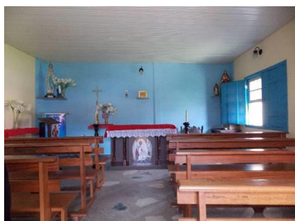
Figura 31: Forro PVC Capela Nossa Sra. De Lourdes – Vila São José. Ouro Preto, MG. Fonte: Luana Redini, 2015.
