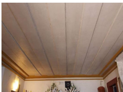
Figura 29: Forro tipo saia e camisa sacristia Capela de Santana, Ouro Preto, MG. Fonte: Luana Redini, 2015.
