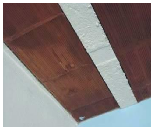
Figura 41: Forro plano em laje pré-moldada Capela N. Sra. De Lourdes – Morro S. Sebastião. Fonte: MOREIRA, 2015.
