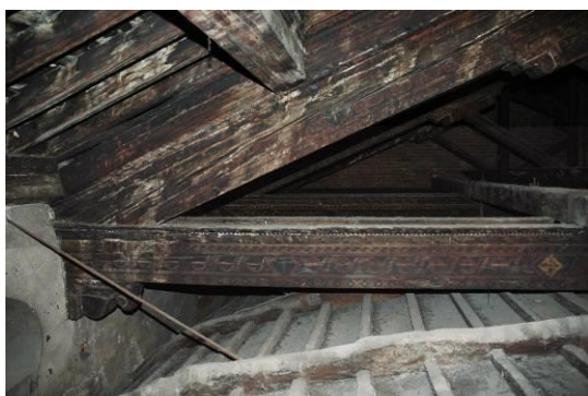
Figura 46: Detalhe estrutura tesoura da cobertura da igreja de Sant'Egidio. Firenze, Itália. Fonte: RIEL, Silvio Van, 2009.
