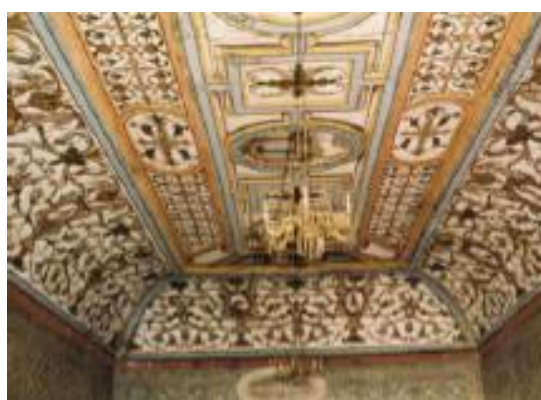
Figura 38: Forro sanqueado, artesoado da sacristia da Igreja de Sé de Viseu, Portugal. Fonte: MOREIRA, 2015.
