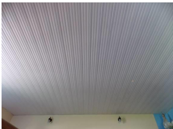
Figura 40: Forro plano em PVC Capela N. Sra. Lourdes – Vila São José. Ouro Preto, MG. Fonte: Luana Redini, 2015.
