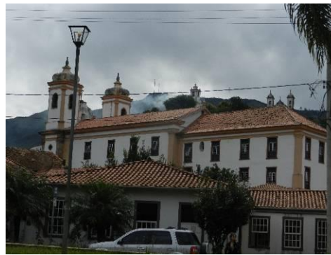
Figura 56: Telhado Igreja Matriz do Pilar. Ouro Preto, MG. Fonte: Luana Redini, 2015.
