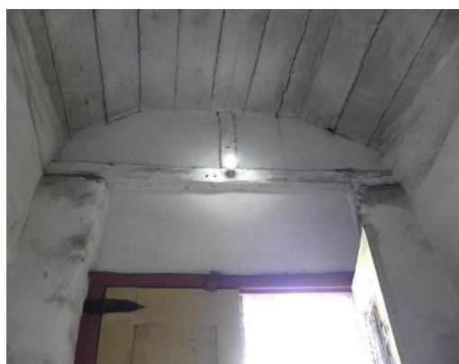
Figura 21: Forro trifacetado capela de Santa Cruz – Alto da Cruz. Ouro Preto, MG. Fonte: Luana Redini, 2015.
