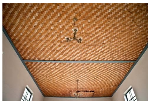
Figura 34: forro capela de São José do Manso. Ouro Preto, MG. Fonte: Luana Redini, 2015.
