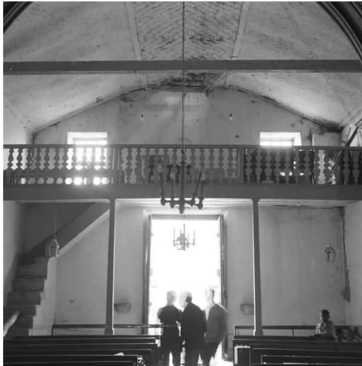
Figura 22: Forro nave Capela de São João Batista de Ouro Fino. Detalhe forro em esteira de taquara. Ouro Preto, MG, s/ data. Fonte: acervo da Escola de Arquitetura da UFMG, Laboratório de Foto documentação Sylvio de Vasconcellos.
