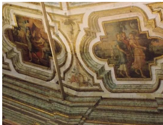
Figura 50: Detalhe tirante nave Igreja Matriz do Pilar. Ouro Preto, MG. Fonte: Luana Redini, 2015.
