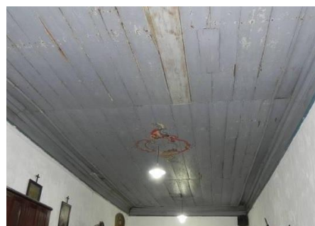
Figura 32: Forro junta-seca sacristia Capela Bom Jesus de Matosinhos. Ouro Preto, MG. Fonte: Luana Redini, 2015.
