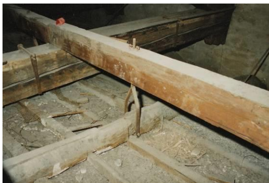
Figura 47: Detalhe amarração extradorso abóbada Da igreja de Sant'Egidio. Firenze, Itália. Fonte: RIEL, Silvio Van, 2009.
