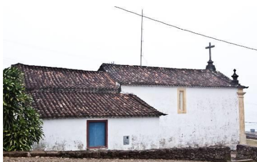
Figura 53: Telhado Capela de Santana. Ouro Preto, MG. Fonte: Luana Redini, 2015.
