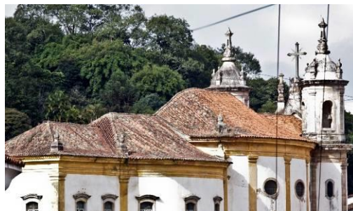
Figura 58: Telhado Igreja Rosário dos Pretos. Ouro Preto, MG. Fonte: Luana Redini, 2015.
