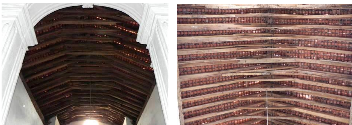
Figuras 44 e 45: Caibro armado exposto da nave capela de Bom Jesus e Matosinhos. Ouro Preto, MG. Fonte: Luana Redini, 2015.
