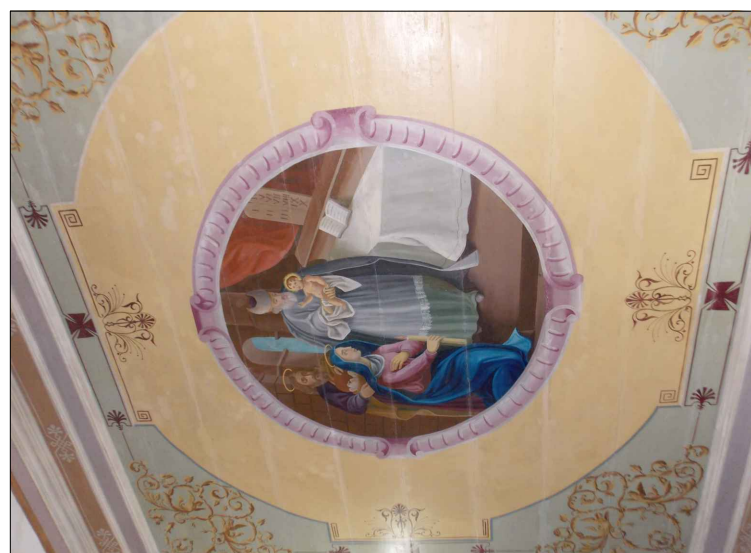
1. Forro plano em madeira
