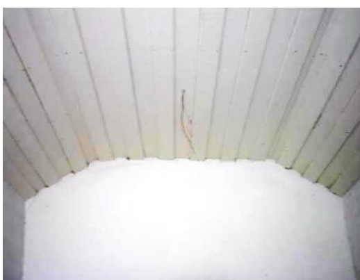
Figura 20: Forro trifacetado capela de Nossa Senhora das Necessidades. Ouro Preto, MG. Fonte: Luana Redini, 2015.
