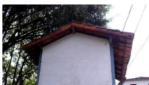
Figura 52: Detalhe telhado de duas águas da Capela da Cruz e das Almas. Ouro Preto, MG. Fonte: Luana Redini, 2015.
