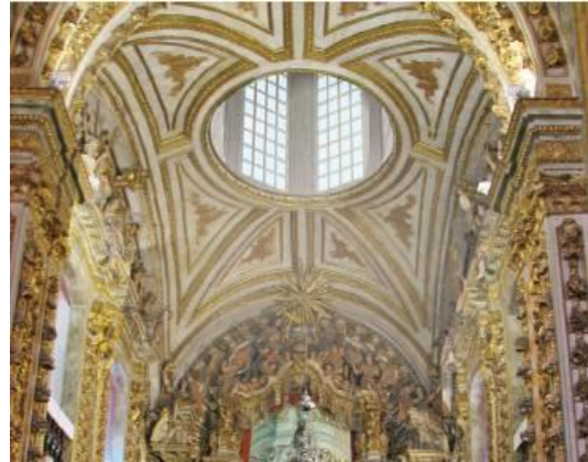
Figura 19: Projeção zimbório forro capela-mor Igreja Matriz Pilar. Ouro Preto, MG. Fonte: BASTOS, 2009, p.167. (Computação gráfica de Robson Godinho)
